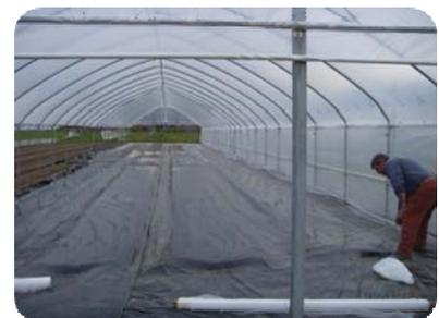
Foto 1: Copertura con film di PVC e pareti laterali con reti anti insetto
